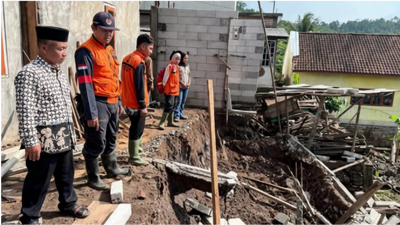
Petugas darurat dan warga meninjau kerusakan parah akibat tanah longsor yang merobohkan sebagian struktur bangunan.
